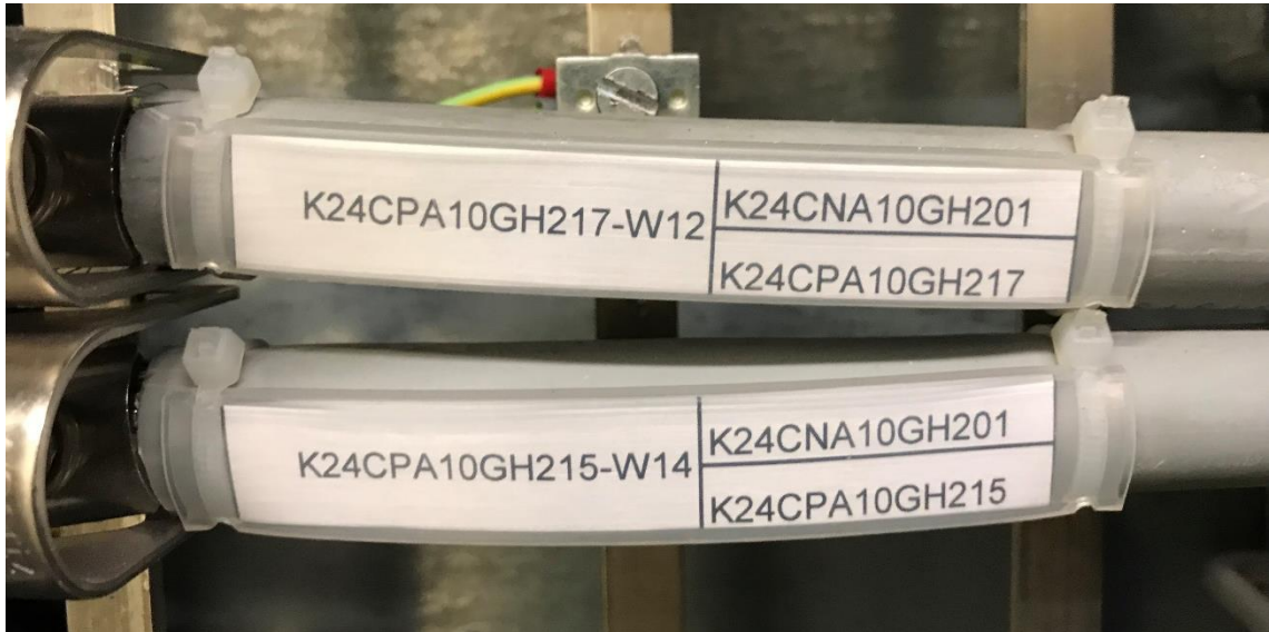
Abbildung 8: Beschilderung Elektrische Kabel
