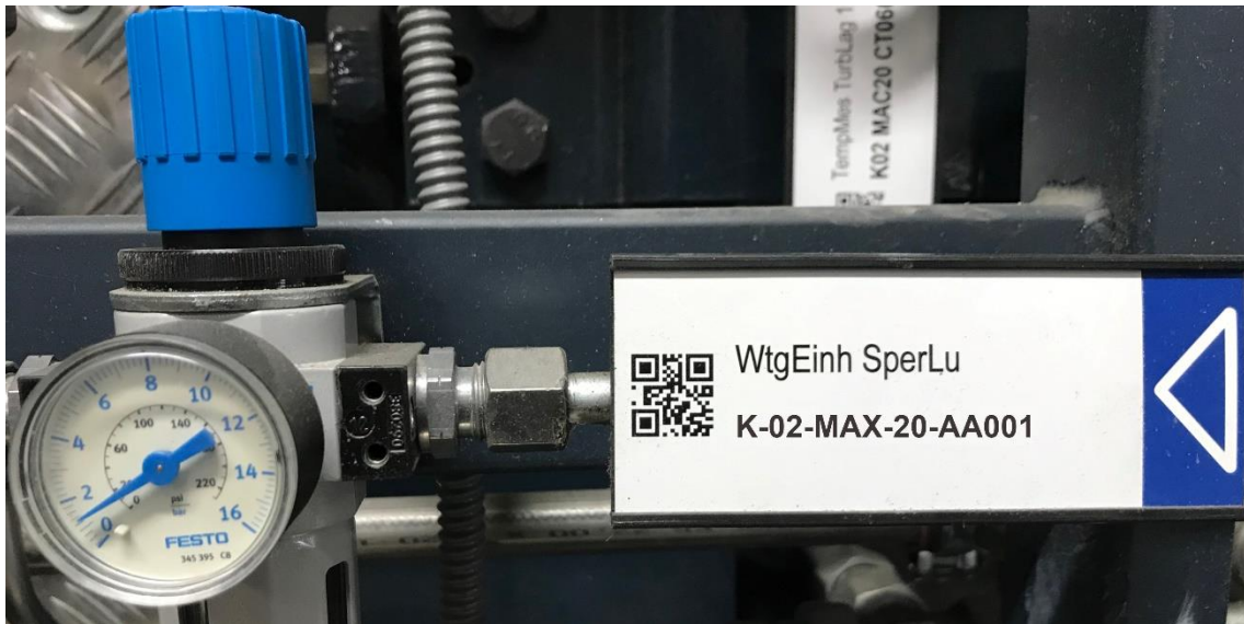
Abbildung 2: Beschilderung Aggregate und Equipment
